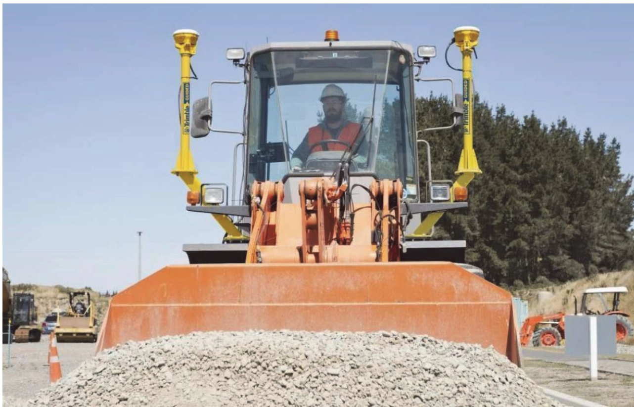
Slika 19. Primjer uporabe 3D upravljanja građevinskim strojem
